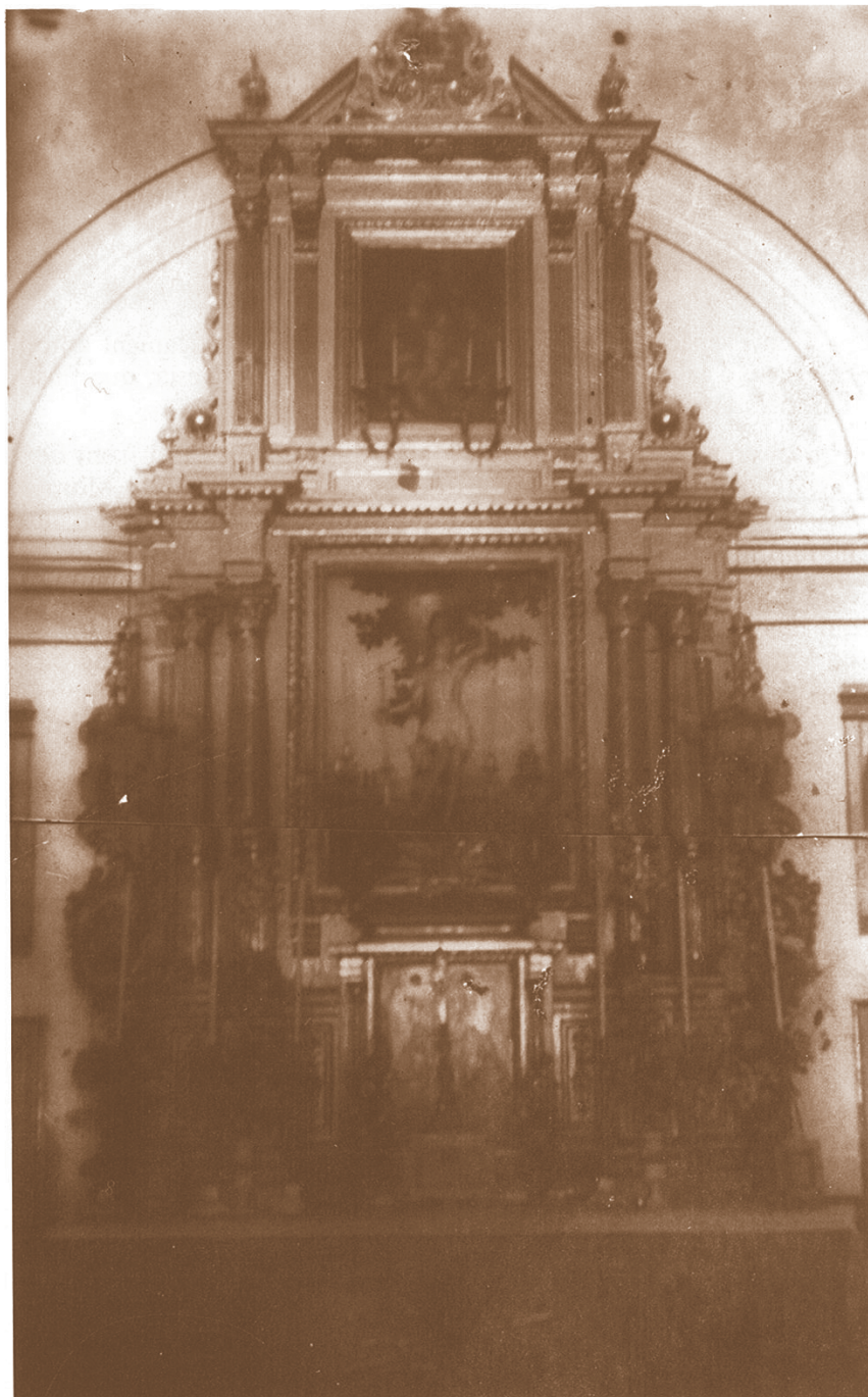
Altar Major de Rocafort abans de la seua destrucció en 1936
